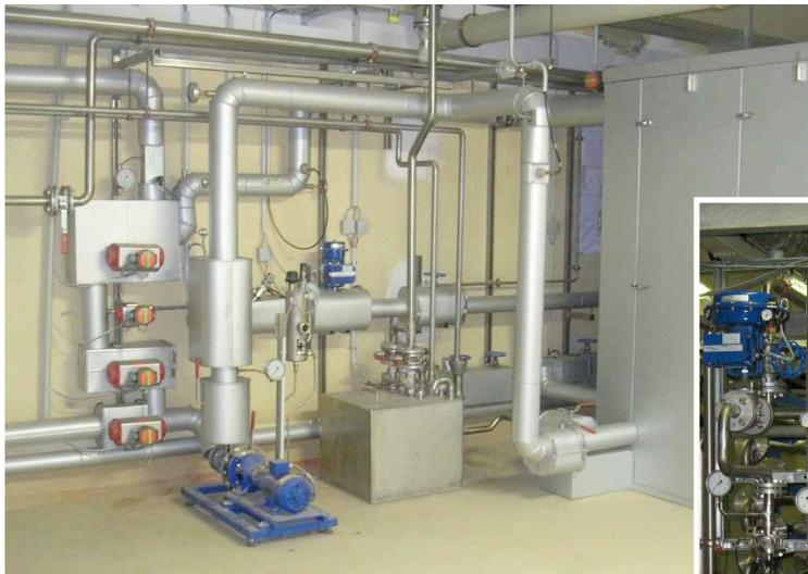
**Verweilstufen 3 m<sup>3</sup>/h, 121°C, 20 min.
