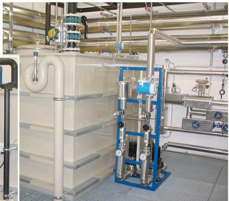
**Pufferbehälter 12m<sup>3</sup> mit Verweilstufe u. Kühlung**
