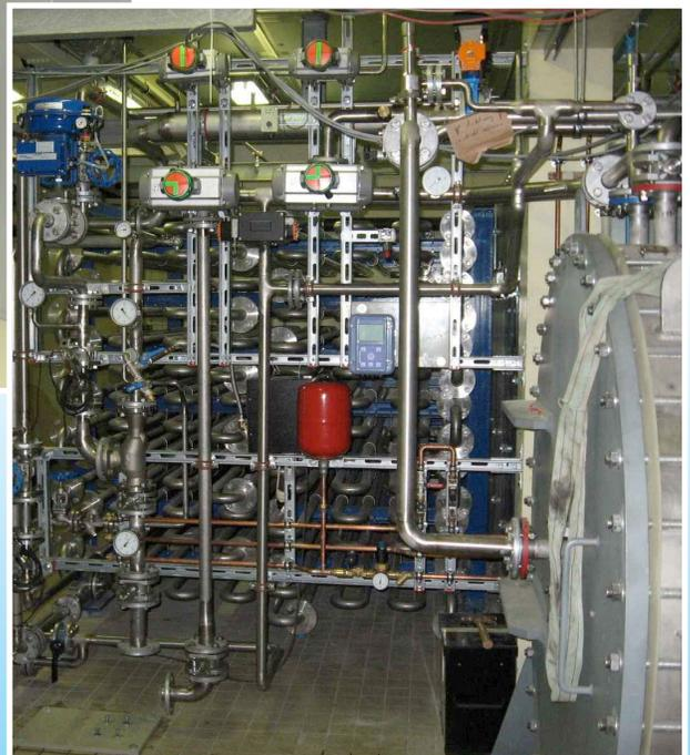
**Geöffnete Verweilstufen 3 m<sup>3</sup>/h, 121°C, 20 min.
