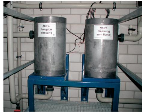
**Aktivitätsmessanlage mit Bleiabschirmung zur Überwachung des Kanalabgangs**
