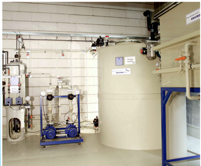
Max-Planck Institut, Heidelberg: Neutro-Fix Reaktor, 15 m³/h mit Vorlagebehälter und Abscheider
