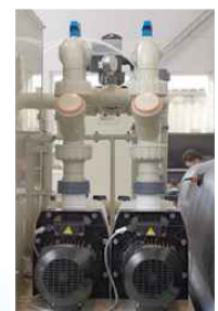
redundante Chemiepumpe
