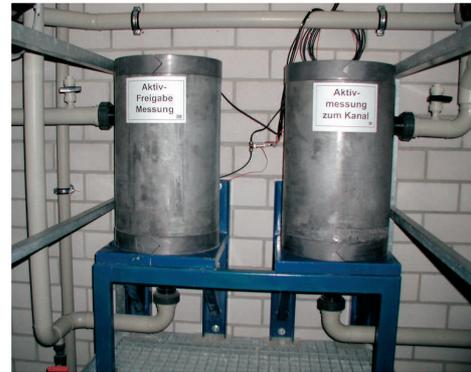
**Aktivitätsmessanlage mit Bleiabschirmung zur Überwachung des Kanalabgangs**
