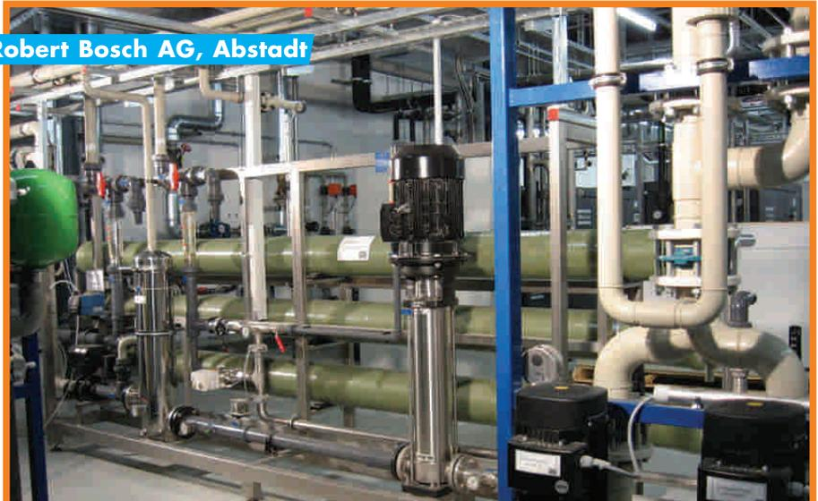
Umkehrosmose mit Härttestabilisierung, Leistung 15 m<sup>3</sup>/h zu Aufbereitung von Nachspeisewasser für Kühlwasserkreisläufe
