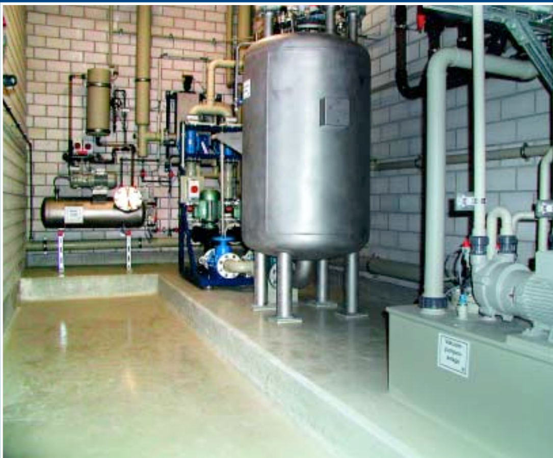
Vakuumbstation mit Fäkalienzerkleinerungspumpen: vakuumfester Druckbehälter mit nachgeschalteten Zerkleinerungspumpen, Be- und Entlüftungsstation der Abklingbehälter einschließlich Filtereinheit.
