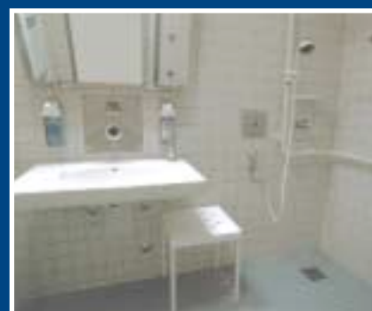
Automatische Hand- und Dusch-Armaturen
