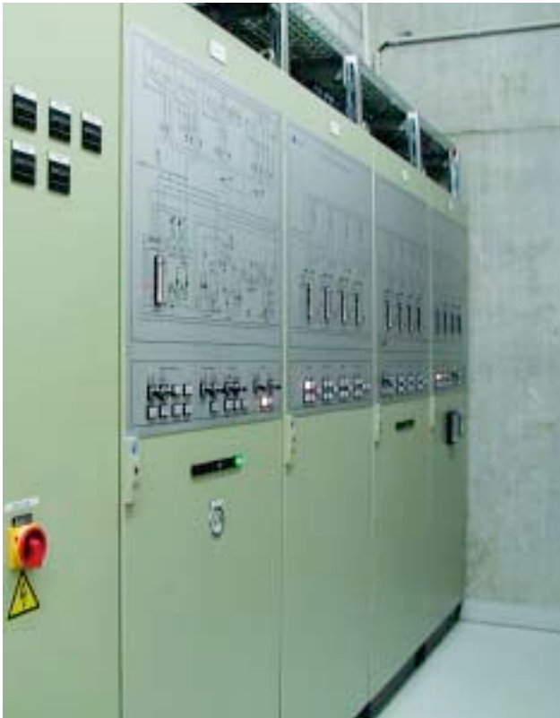
Zentraler Schalt- und Steuerschrank mit eingebauter SPS, an den Türen montierte Fließbilder mit Leuchtdioden, Füllstandsmessungen und Bedienelementen.
