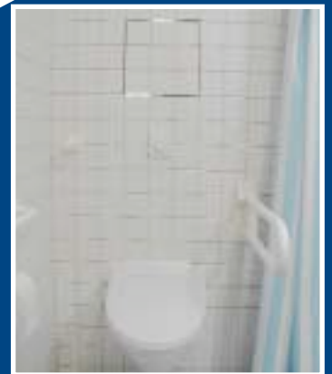
Vakuumtoilette mit einem Wasserverbrauch von 2l pro Spülung.
