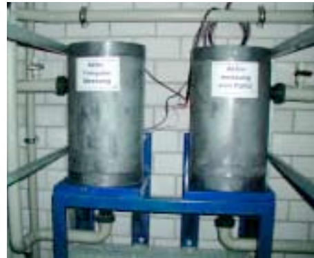
Aktivitätsmeßanlage mit Bleiabschirmung zur Überwachung des Kanalabgangs.
